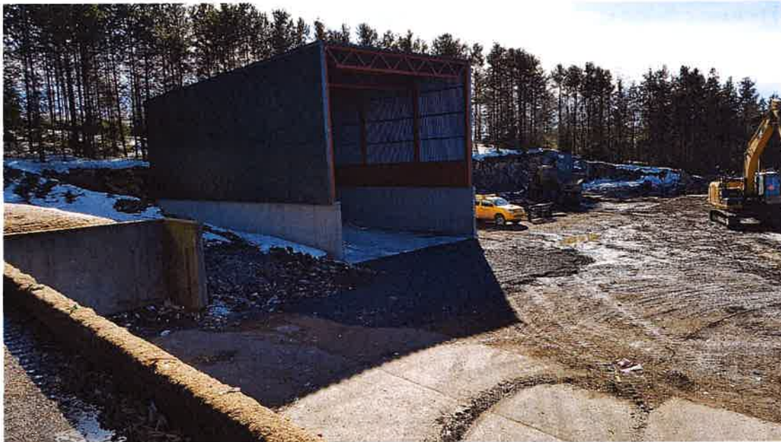
Nytt lager for gipsavfall i 2019
